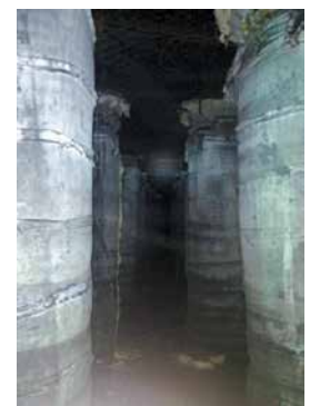
Рис. 4. Гибкая опалубка опорных колонн
