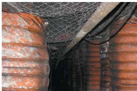
Рис. 4. Гибкая опалубка опорных колонн
