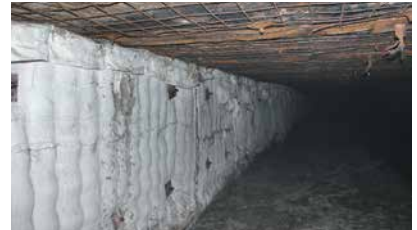
Рис. 3. Гибкая опалубка бутовой полосы
